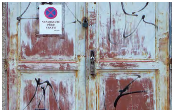
Stav před montáží
